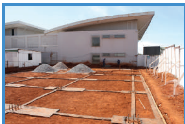
Imagem 08 - Preparação para recebimento da estrutura metálica.
