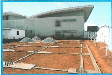
**Imagem 08** - Preparação para recebimento da estrutura metálica.
